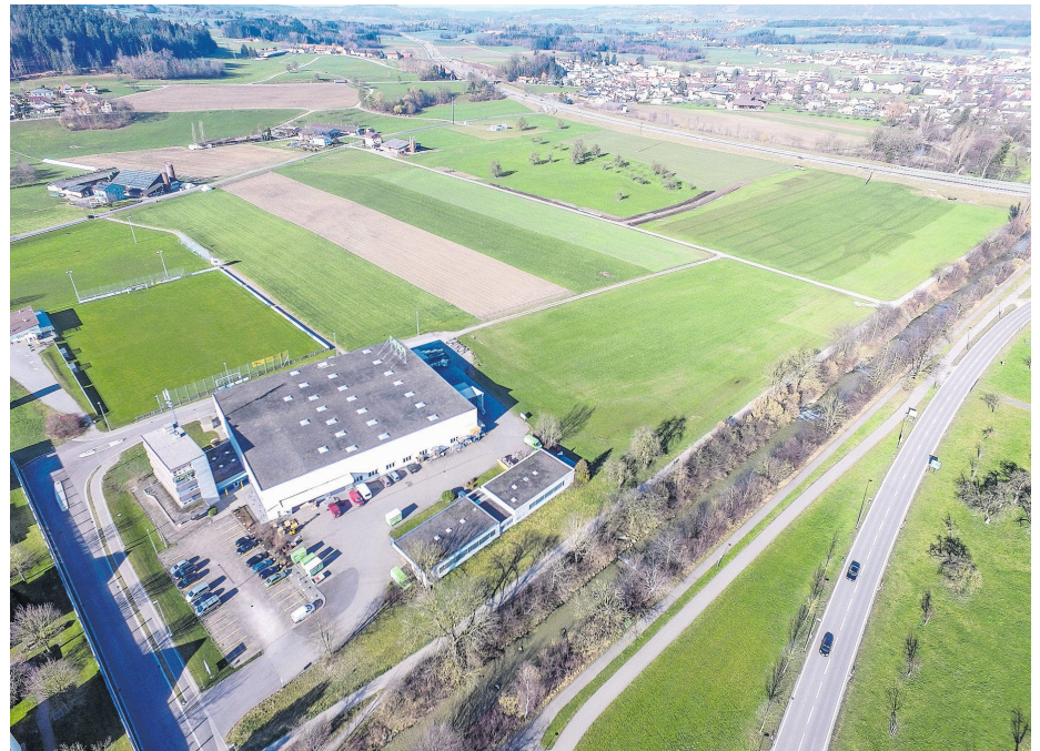
Der Fachmarkt Ebnet entsteht zwischen der Portas AG und der Autobahn A1.
