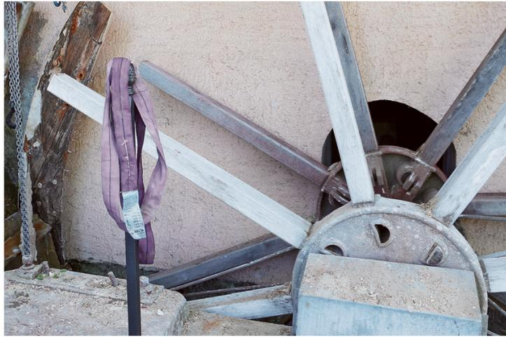
Um die Achswelle mit Rosette wird ein neues Rad gebaut und anschliessend an die ursprüngliche Position bei den Schrauben im Boden links versetzt.
